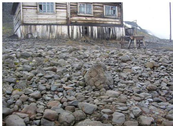
после очистки и рекультивации
