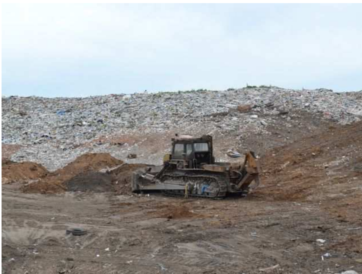
Фото 3.2.6-6. Полигон ТБО «Игумново», г. Дзержинск [208].
